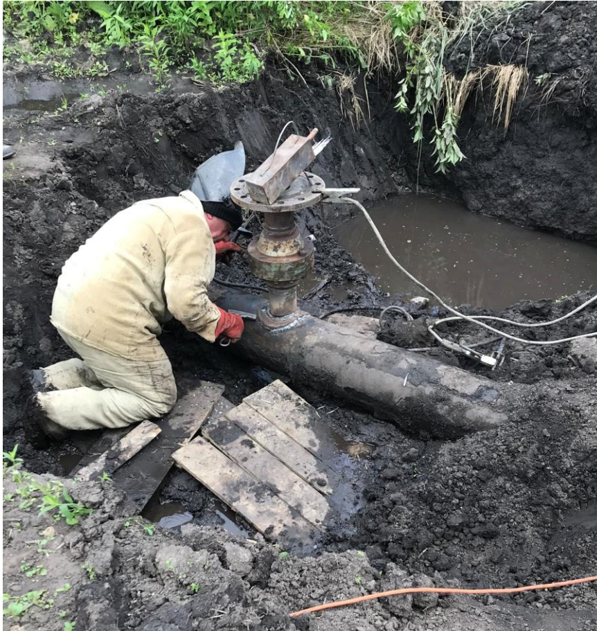
Рис. 1. Виконання приварювання вузла відводу DN 100 до газопроводу DN 250
