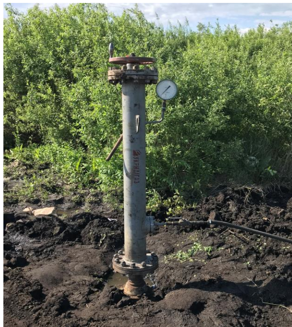
Рис. 5. Змонтований Пристрій для видалення рідини з внутрішньої порожнини трубопроводу
