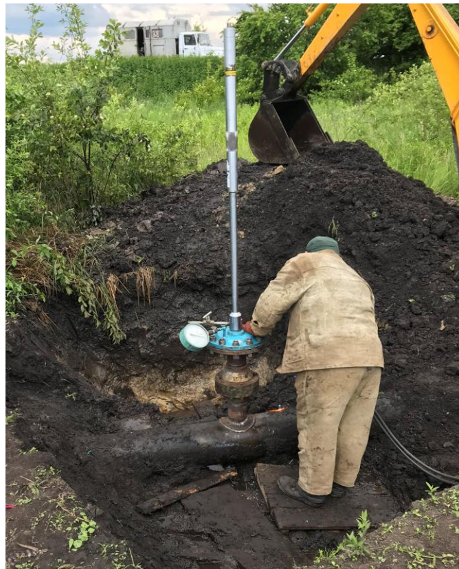
Рис. 3. Вирізання отвору в газопроводі ручним свердлильним механізмом моделі T-101b XL
