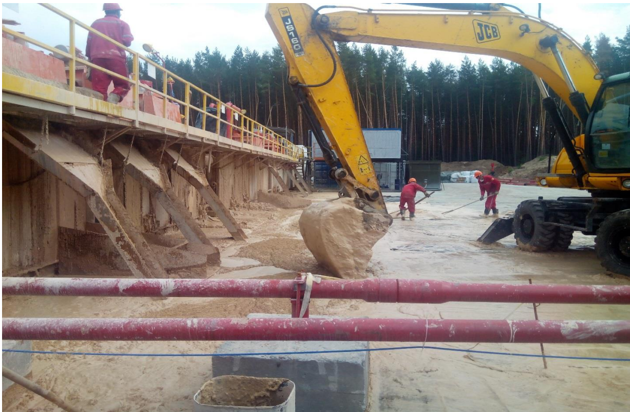
Рис. 1. Ліквідація наслідків переливу розгазованого розчину з уявною густиною 200-600 кг/м 3 з жолобів і вібросит в процесі циркуляції від 27.07.2018 р.
