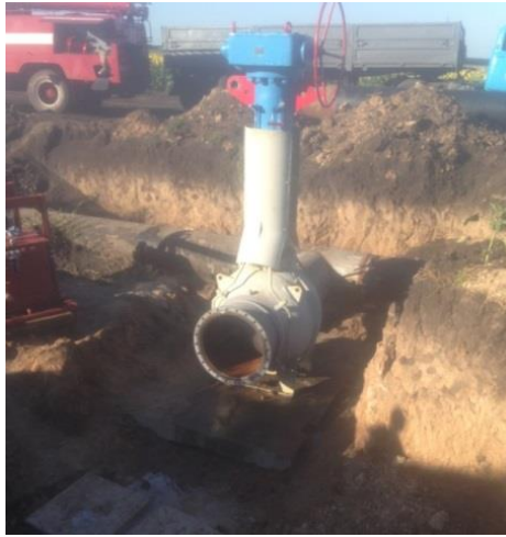
Рис. 2. Кульовий кран DN 700 з патрубками та технологічним фланцем, приварений на газозбірному колекторі DN 700
