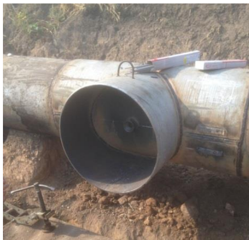
Рис. 1. Загальний вигляд вузла приєднання відгалуження типу «Розрізна муфта з патрубком DN 700», привареного на газозбірному колекторі DN 700
