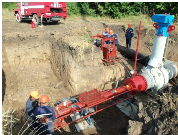
Рис. 3. Машина для візок з гідравлічним приводом моделі TM-1200H фірми TD Williamson з корпусним адаптером, змонтована до вузла приєднання відгалуження
